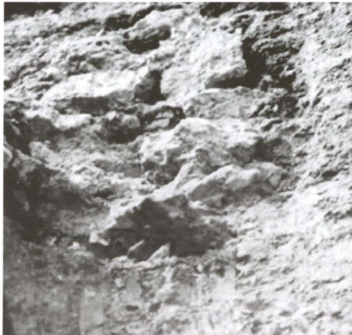
Fig. 31 – Fundação de um muro no transepto
