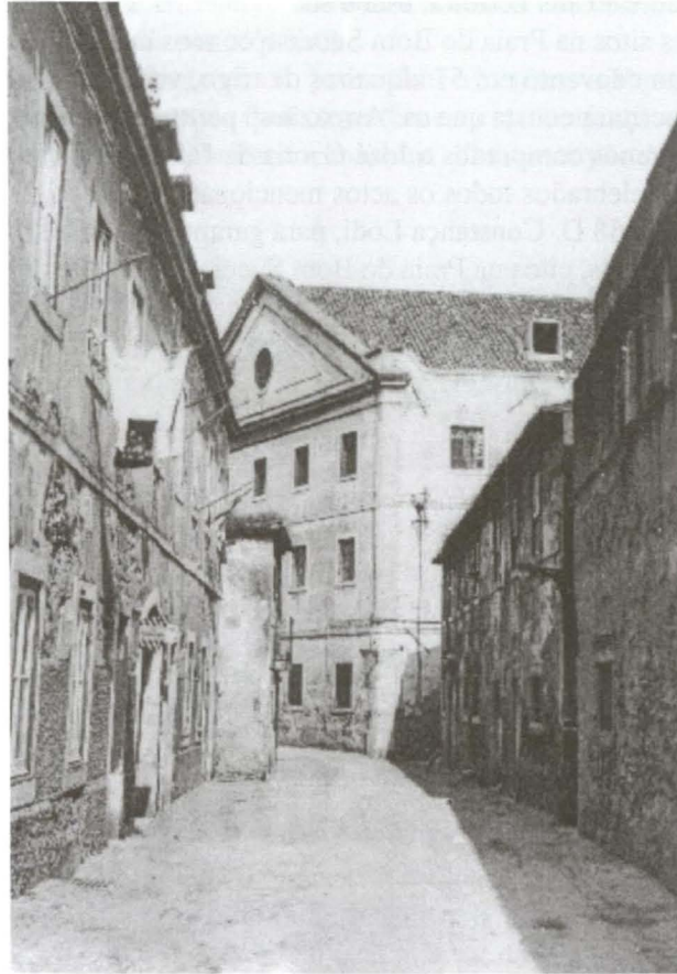
Fig. 1. Rua da Praia do Bom Sucesso. Ao fundo a extremidade ocidental do edifício da fábrica (Arquivo Fotográfico Municipal)
