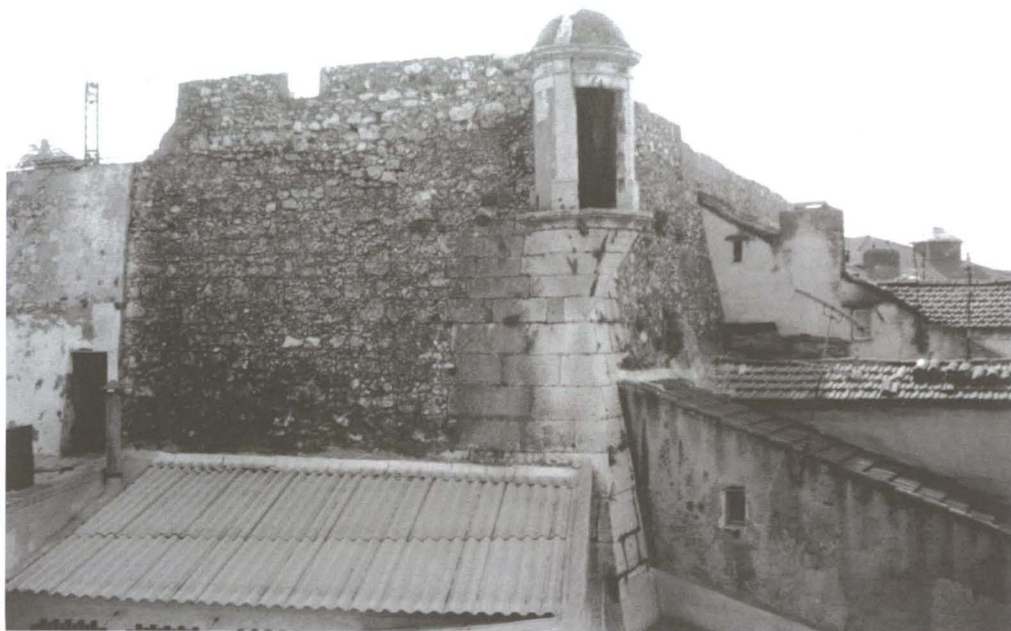
Fig. 12. Vista exterior do baluarte tirada de noroeste. São visíveis a guarita do cunhal e parte do terrapleno norte, note-se a inexistência de cordão nas muralhas
