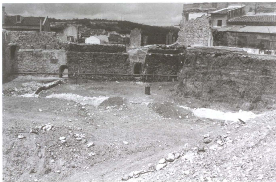
Fig. 10. Vista de sul do terraço superior durante a sua escavação.
