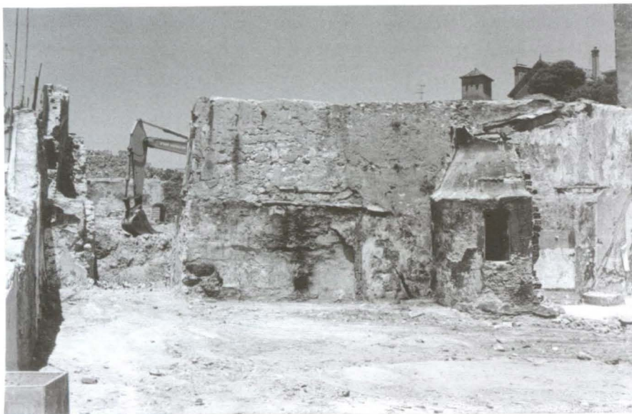
Fig. 9. Vista de sul do terraço sul. São visíveis a entrada da rampa para o terraço superior e a guarita da entrada do paiol, alterada pela sua reutilização
