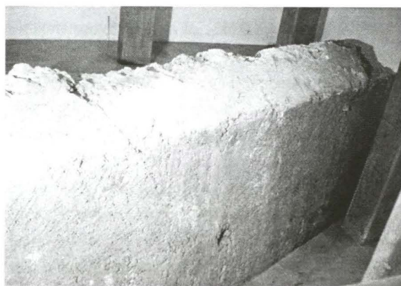
9. Troço da muralha Sul do baluarte filipino integrado no museu.
