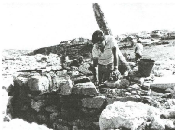
2. Pormenor dos trabalhos de restauro e consolidação de estruturas arqueológicas, realizados em Leceia.
