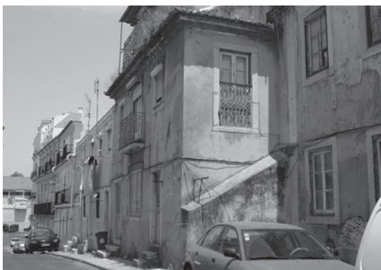
Figura 5 – Rua da Bela Vista à Graça – notam-se os desníveis nas soleiras das portas, provocadas por uma reorganização formal da rua. Foto do autor.
