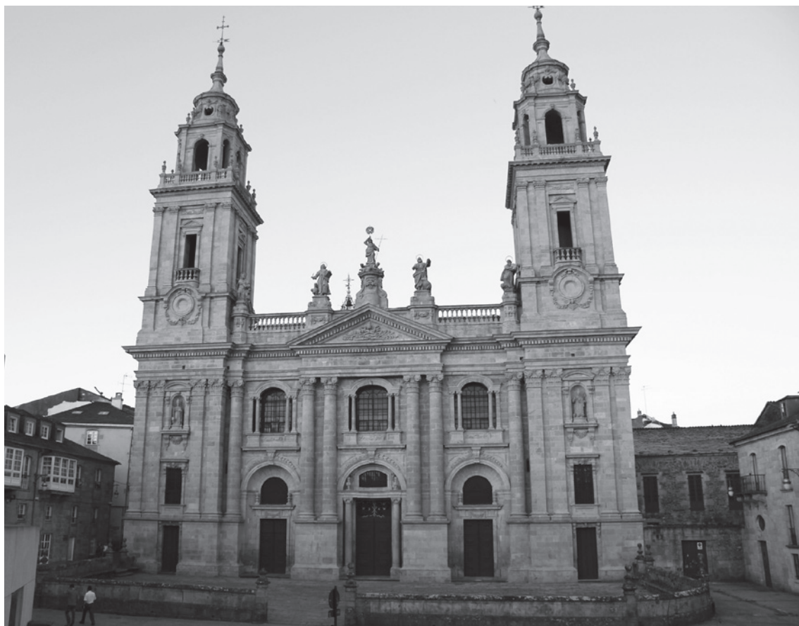
Figura 9 – Fachada de la catedral de Lugo. Juliá Sánchez Bort (1769-85).
