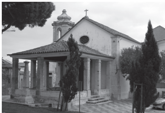
Figura 4 – Capela de S. Gens / Nossa Senhora do Monte, reconstruída em inícios do século XIX pelo arquitecto Honorato José de Correia Macedo e Sá. Foto do autor.
