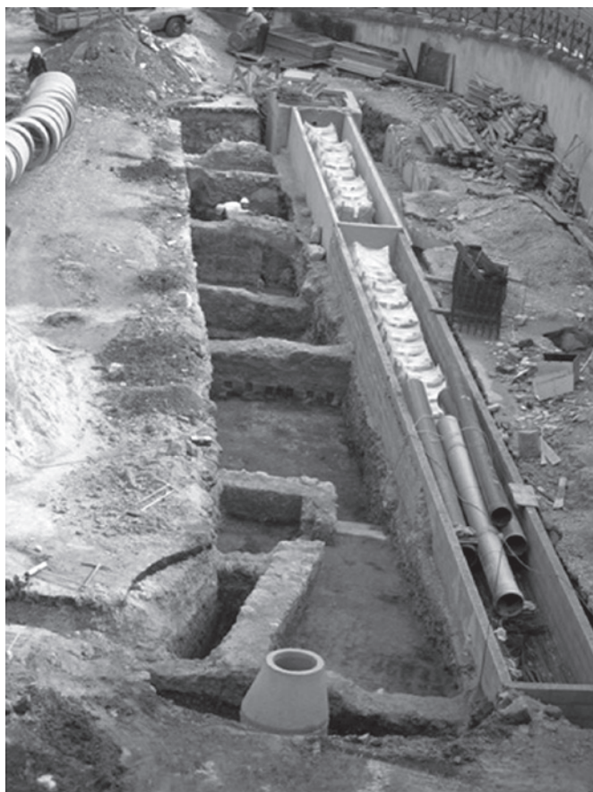
Figura 1 – Vista geral da escavação.
