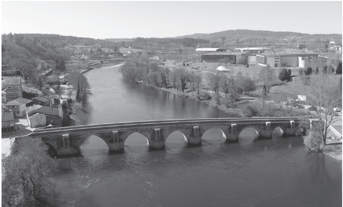
Figura 1 – Vista del puente romano de Lugo.
