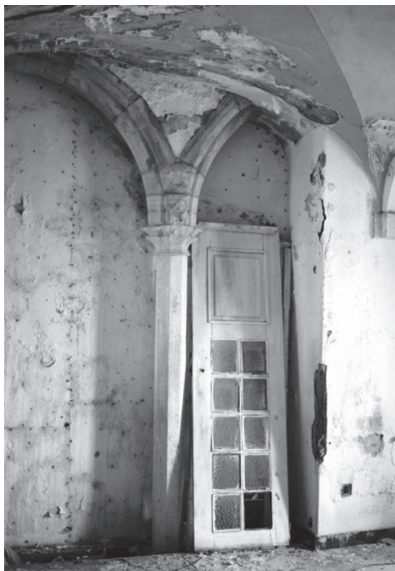
Figura 3 – Coluna e restos de estruturas ainda do período da Graça II (manuelino), integrados na reconstrução posterior a 1765. Foto do autor.
