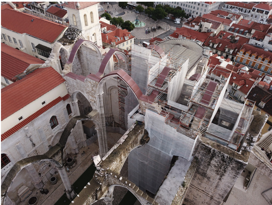
Figura 1 – Obras de conservação e restauro da zona do transepto do Museu Arqueológico do Carmo.
