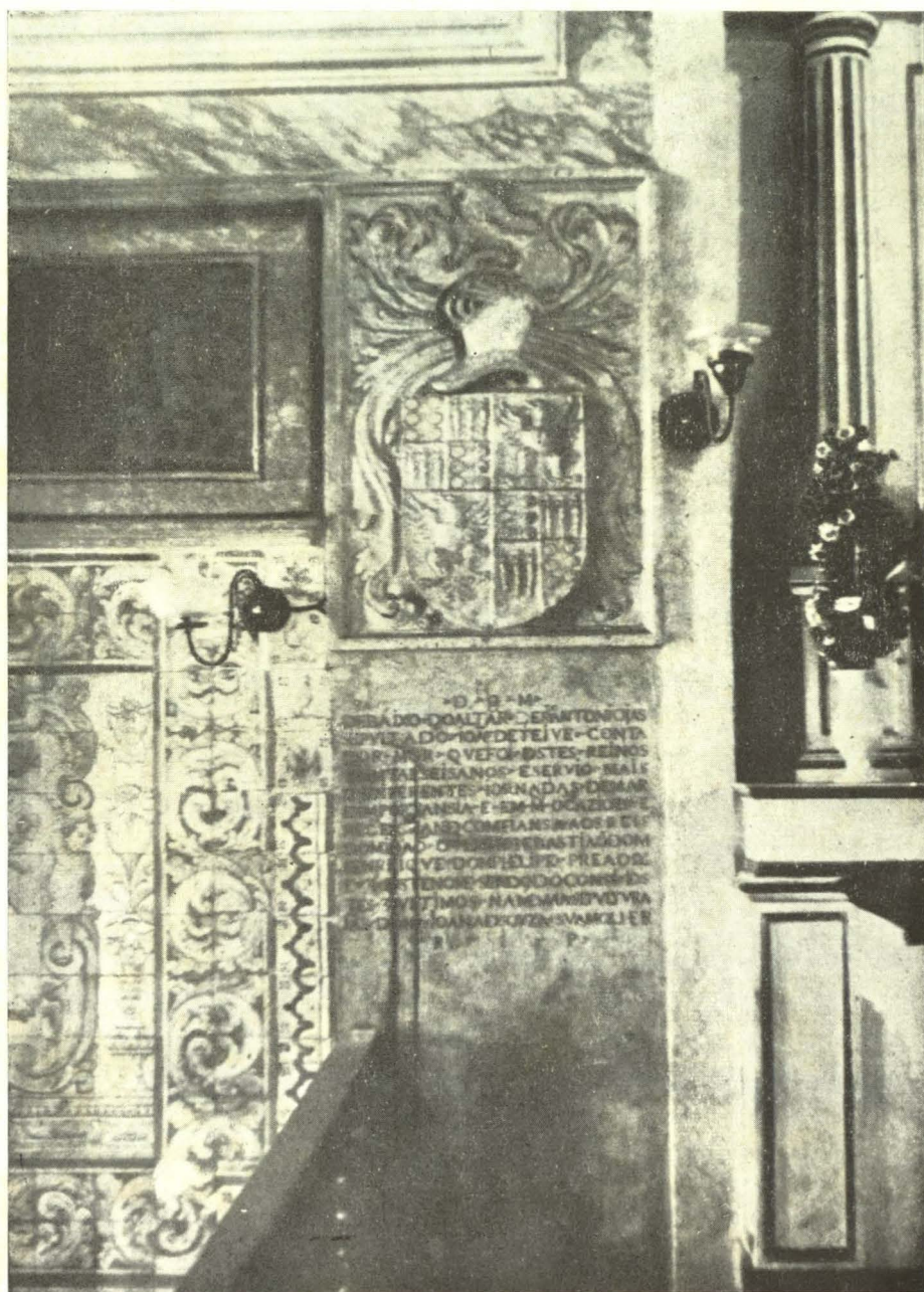
Interior da capela-mor da igreja do Convento do Barro
