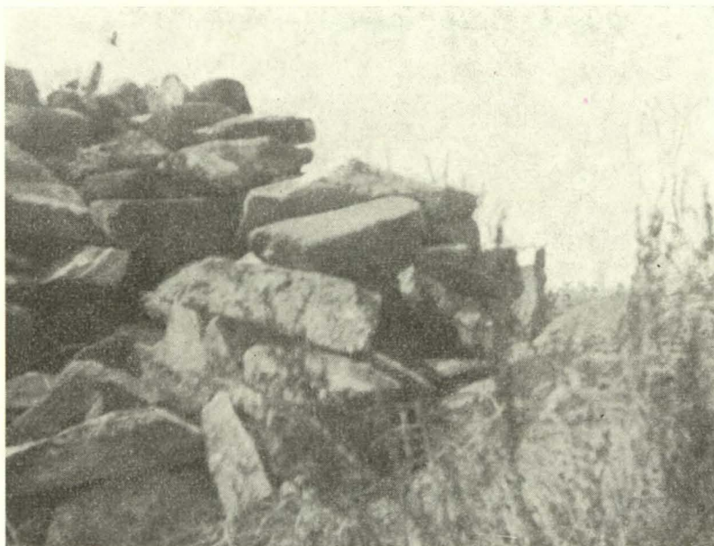
Muralha desmoronada, no complexo do Monte Nhamara.
