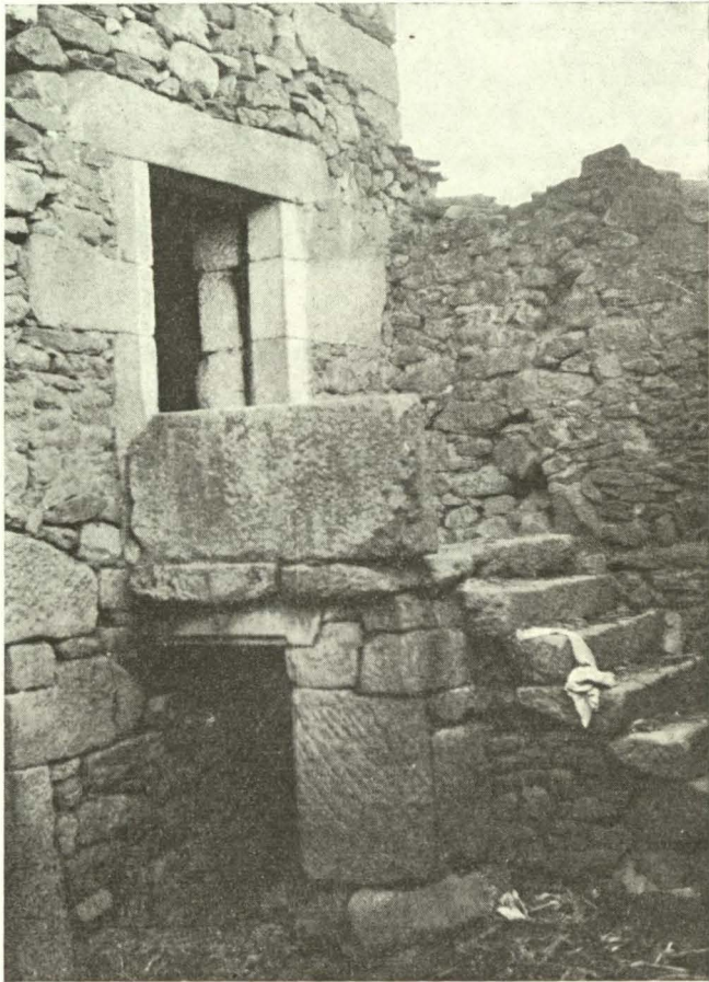
Fig. 2 — As ruínas da casa que «foi Tribunal».
