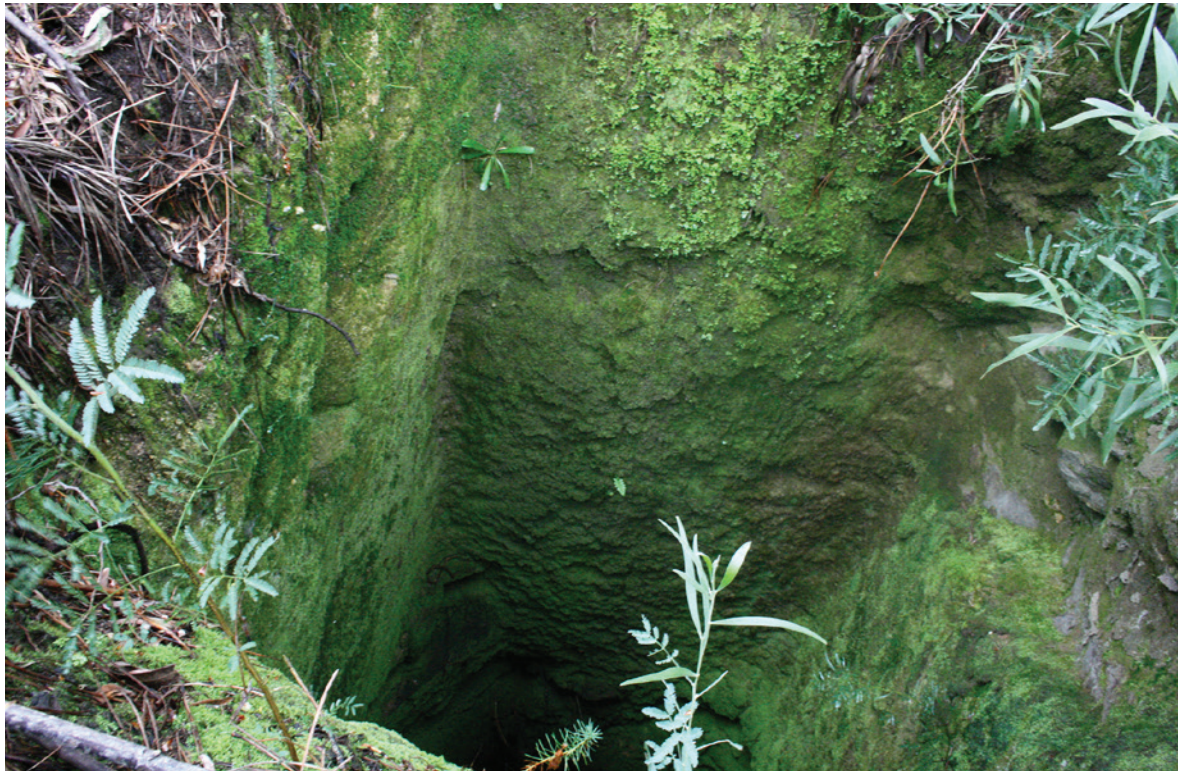
Figura 1 – Poço de mina na Senhora do Castelo, em Vouzela (cl. M. L. Real).
