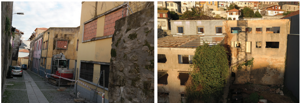
Figura 2 – Vistas da fachada e do alçado tardoz do edifício sito na Rua da Vitória.
