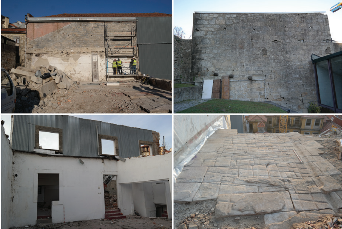
Figura 3 – Vistas dos negativos nas paredes nascente e poente do edifício, das janelas reaproveitadas e do piso lajeado da cocheira.
