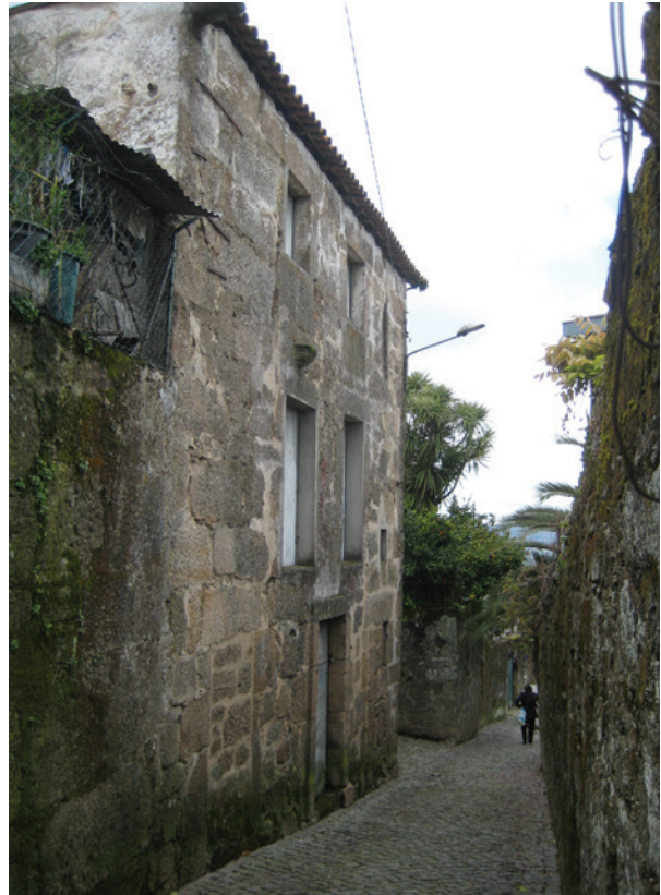
Figura 2 – Fachada do antigo hospital de Arrifana de Sousa.
